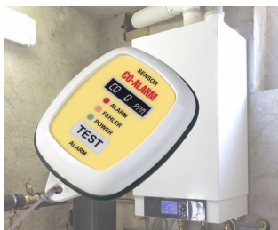
Сигнализатор утечки CO
